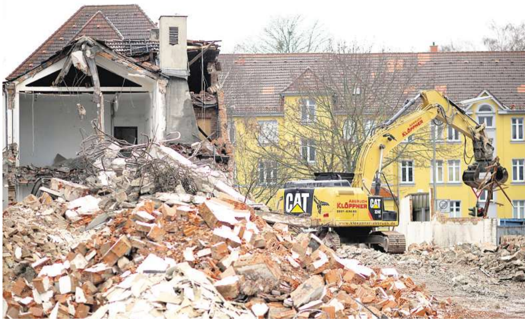
Auf dem alten Sartorius-Gelände sind die Bagger angerückt.
